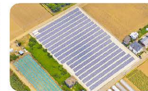
川辺とみさと発電所
